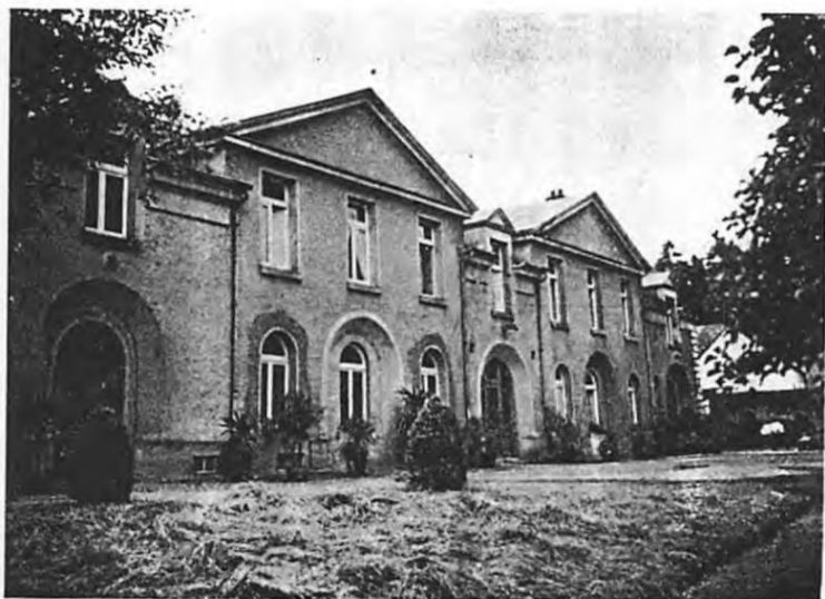
Maison de retraite de Bofferdange
