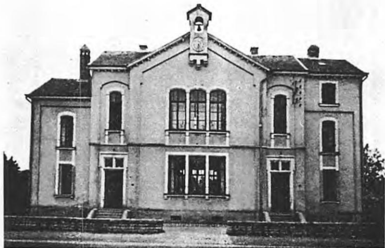
Ecole de Helmdange-Bofferdange
